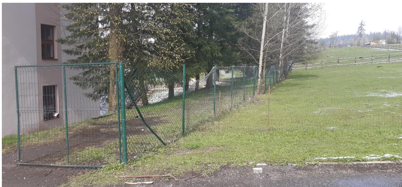
Pôvodný stav pohľad zvonku
